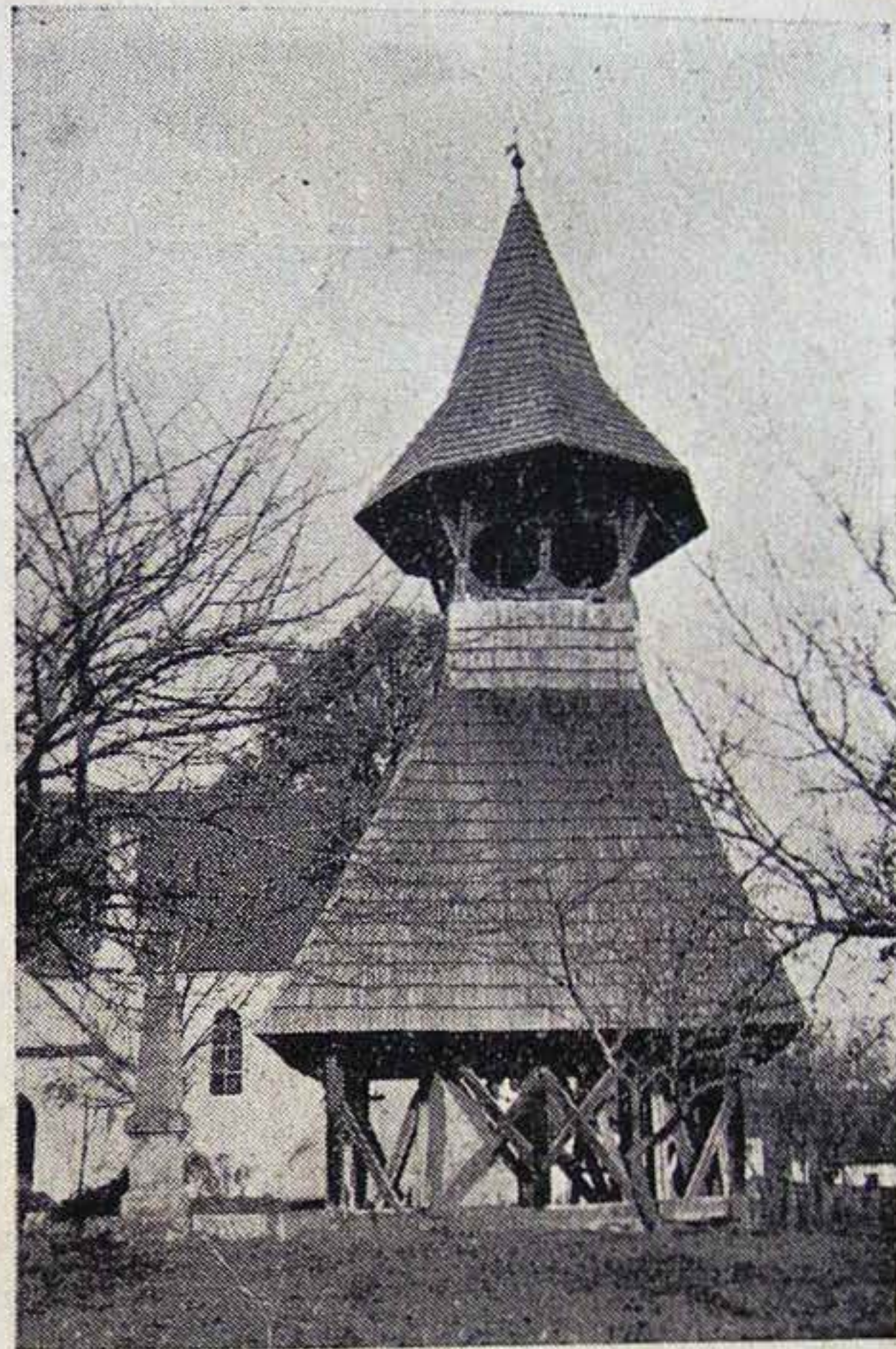
A kálnoki fatorony. (1781.) Magassága 18 méter. Teljesen fejszével és fúróval épült, faszegekkel, fűrészelés sehol sem látszik. Ritka műemlék. (L. Kovács Imre: Adatok a kálnoki egyházközség történetéhez c. könyvét. Kvár, 1936.)
