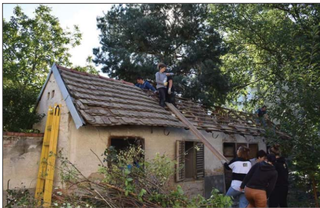
A régi épület elbontása
