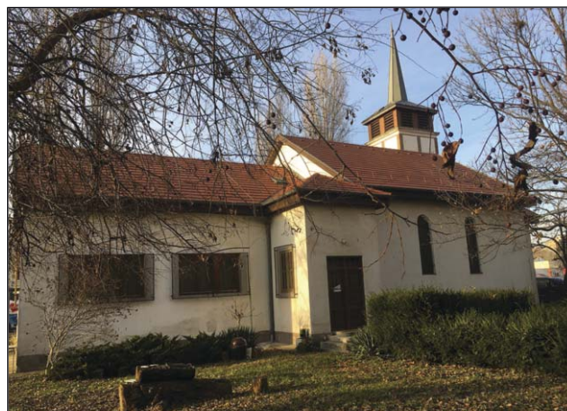
A teljesen felújított torony és tetőszerkezet
